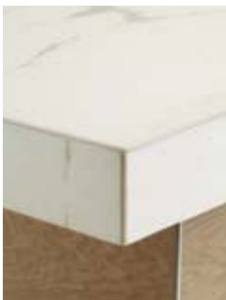
Laminam 5.6mm con terminado estilo redondo aplicado y terminado en el trabajo.
